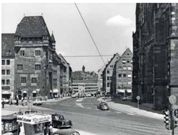
27 Die Königstraße als zentrale Nord-Süd-Verbindung der beiden Stadthälften. Den Blick von der Lorenzkirche zur Burg hatten erst die massiven Kriegszerstörungen freigegeben. 9.6.1969.
