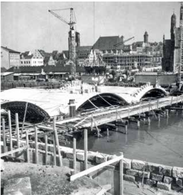
24 Die Museumsbrücke während der Arbeiten zum Hochwasserstollen 1954.
