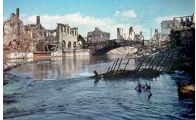
5 Ruinen säumen das Pegnitzufer. Vom ehemaligen Fleischhaus stehen lediglich noch die Mauerreste. Allein die Fleischbrücke ist wiederzuerkennen.
