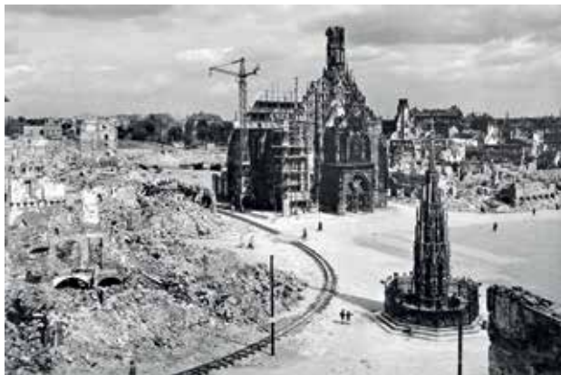
10 Geleise der Schuttbahn am Hauptmarkt. Erste Baumaßnahmen an der Frauenkirche haben bereits begonnen, während der Schöne Brunnen in einen Betonmantel gehüllt die Luftangriffe unversehrt überstanden hat.
